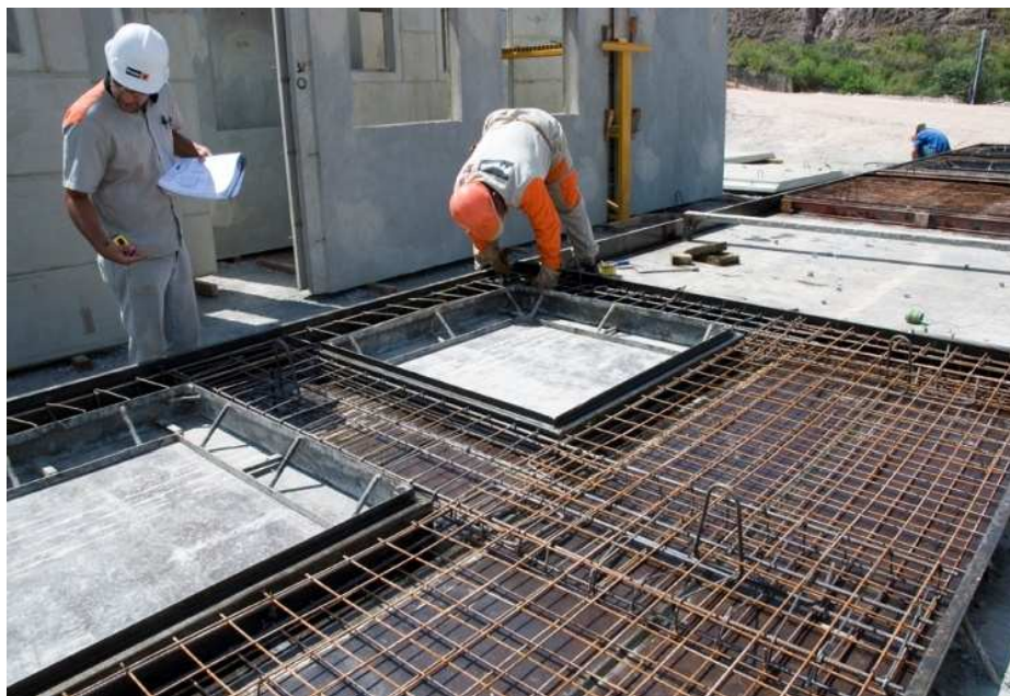
Inserção da armadura
