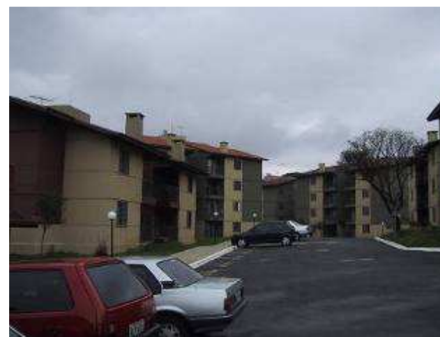
Curitiba/PR Construtora Engeflex
